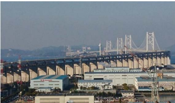
上が道路、下が鉄道の「鉄道道路併用橋」としては世界最大級の瀬戸大橋。
