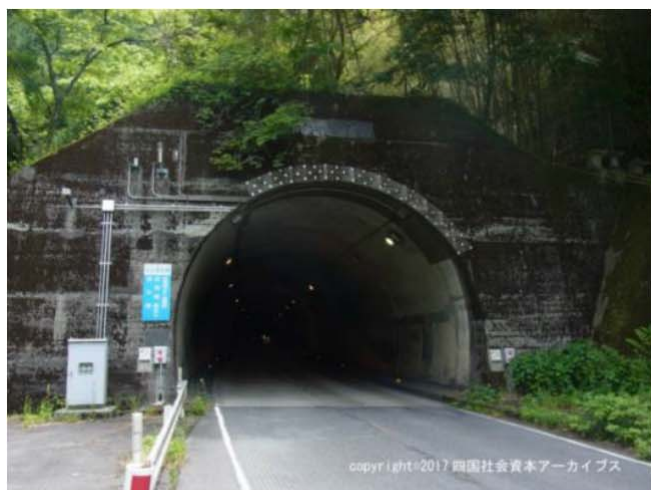
国道197号の高研山トンネル（延長1,562m）
