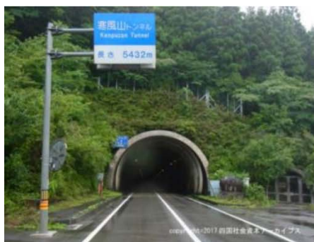
新寒風山トンネル
