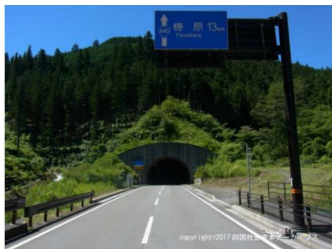
国道440号の地芳トンネル（延長2,990m）
