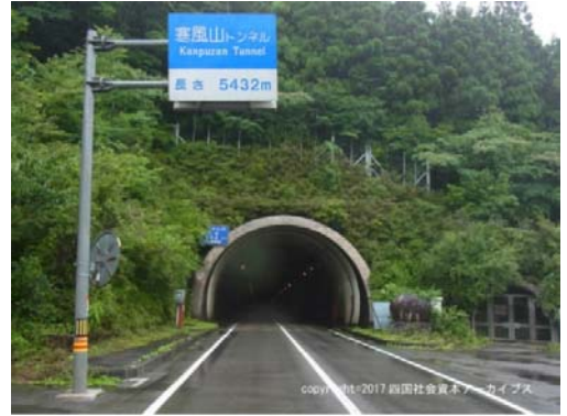
新寒風山トンネル（高知側 坑口）
