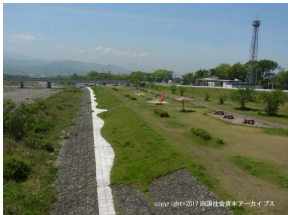
愛媛県東温市の、重信川流路工の様子。
