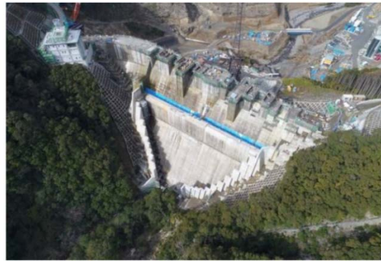
建設中の横瀬川ダムの様子 (平成31(2019)年2月)。
