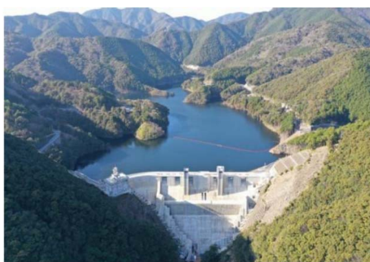
令和 2（2020）年 6 月に完成した横瀬川ダム。
