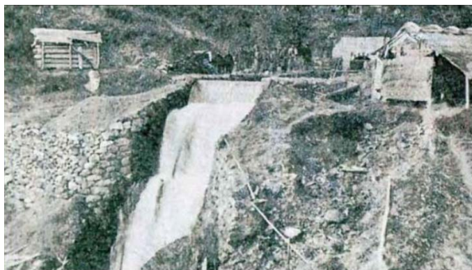
写真1 甫喜ヶ峰疎水出水口 明治 33 年 提供：南国市立教育研究所「南国市のくらし」より
