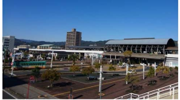
連続立体交差事業で高架化された高知駅
