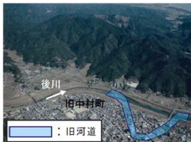
写真11 後川佐岡地先の河道屈曲部の付替
