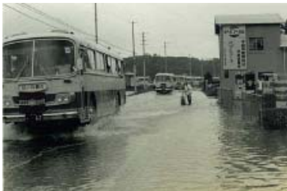
写真6 具同付近の冠水状況(S47年洪水)
