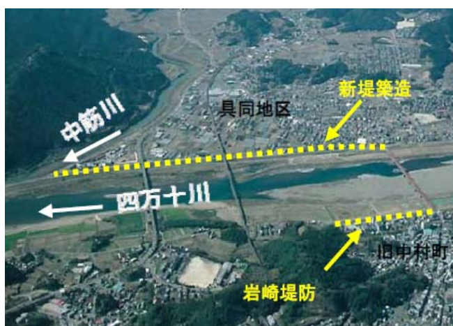
写真10 具同築堤工事、岩崎堤防工事
