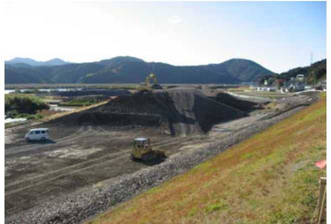
写真 15 不破・角崎堤防事業
