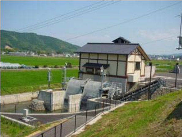
写真 14 川家川排水機場
