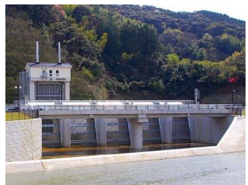
写真－21 宇治川放水路呑口
