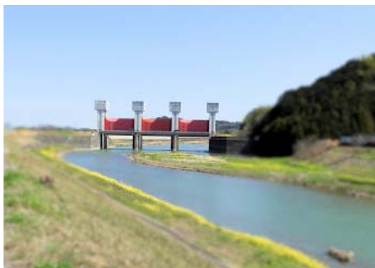
写真－19 波介川水門
