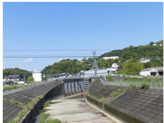
写真－18 日下川放水路呑口
