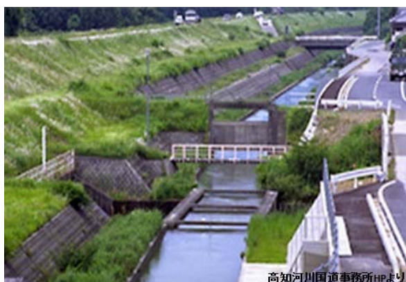
写真－13 現在の用水路と八田の二重堤防
