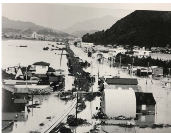
写真－8 昭和50年洪水 (伊野町枝川地区内水氾濫)
