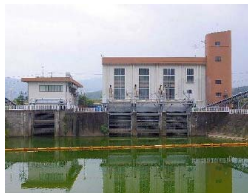
写真－20 宇治川排水機場
