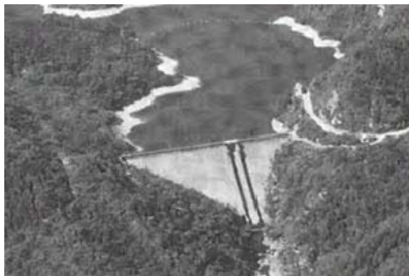
写真－6 別子ダム（昭和 41 年 2 月完成）
