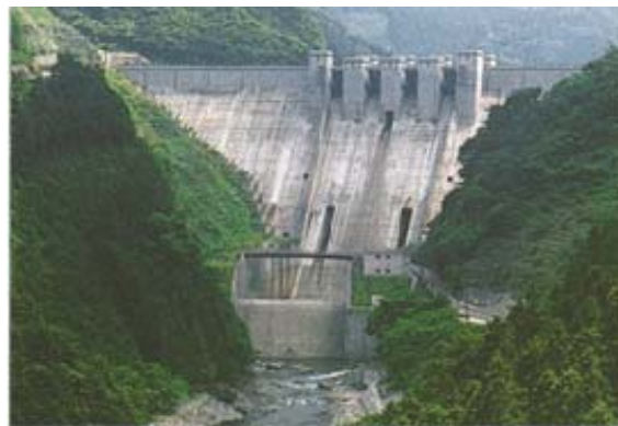
写真－7 富郷ダム（平成 12 年 12 月完成）
