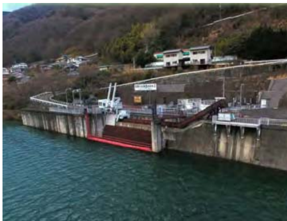
写真-15 吉野川北岸用水の 池田ダム取水口
