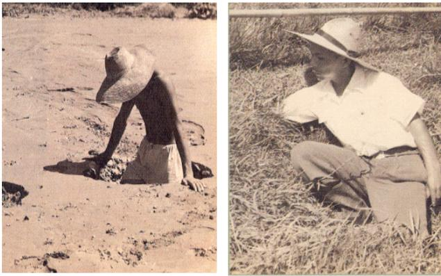
写真 35 基盤漏水噴砂跡（右）堤体漏水空洞（左）（昭和 29 年空洞）
