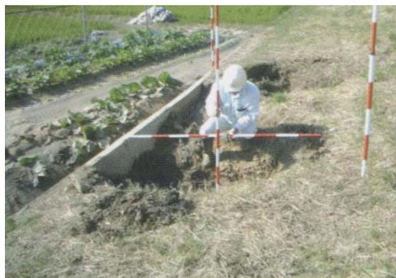
写真 26 堤防漏水の法尻陥没(吉野川市川島町)
