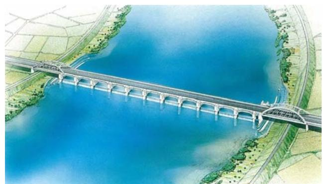
図 15 徳島環状線橋梁との合併構造の可動堰イメージ
