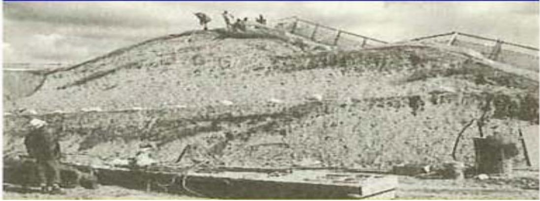
写真 33 吉野川左岸 21.5km 付近の堤防開削調査写真
