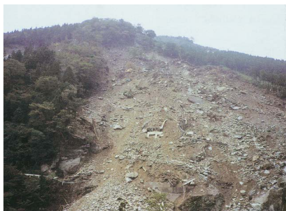
▲地滑りで崩落した工事用道
