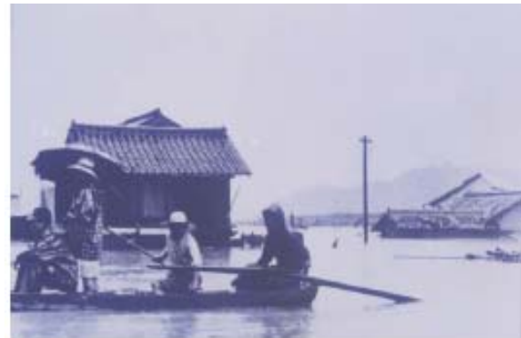
▲昭和 38 年 10 月洪水の氾濫状況
