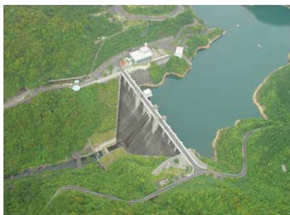
▲中筋川ダム（平成 10 年度完成）
