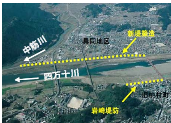
▲具同築堤工事、岩崎堤防工事
