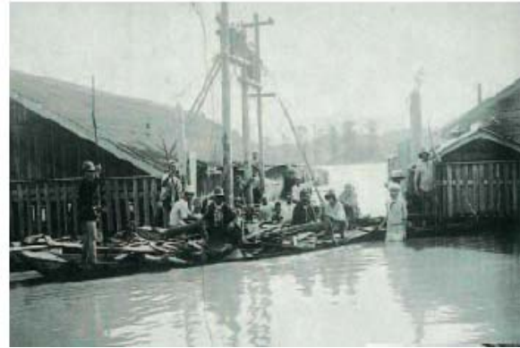
▲昭和 10 年 8 月洪水の氾濫状況
