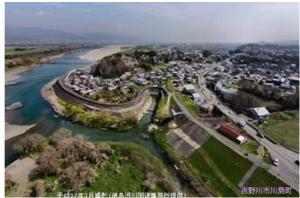
▲麻名用水（南岸）取水口付近
