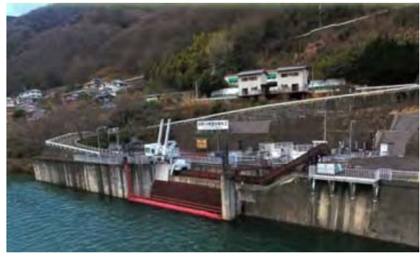
▲吉野川北岸用水の池田ダム取水口
