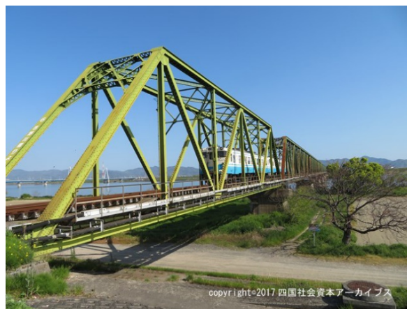
▲高德線の吉野川橋梁
