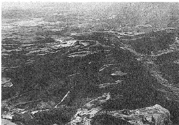
▲昭和 59 年度 本格工事にむけての試験工事を実施[実施土工量 10 万 m 3 ]
