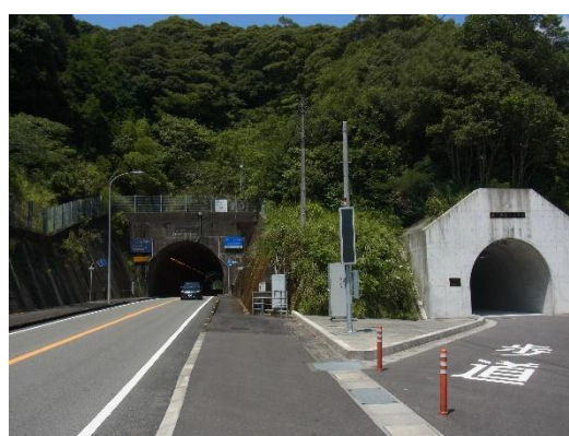
佐川トンネル(左)と佐川歩道トンネル(右)
