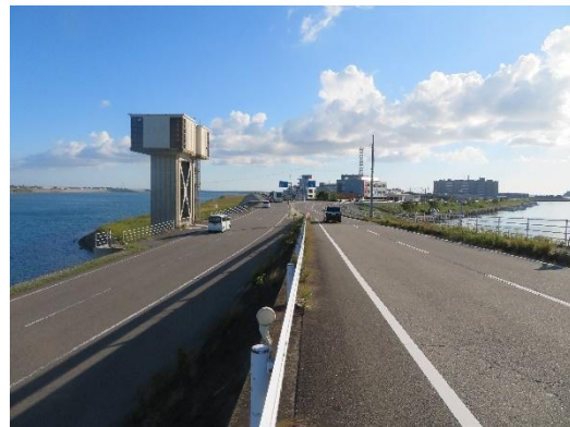
上流から富岡水門をのぞむ （左は那賀川、右は桑野川）
