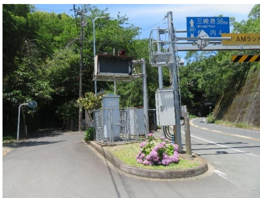
名坂歩道トンネル(左)と名坂トンネル(右)
