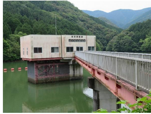
野村ダムの南予用水取水塔
