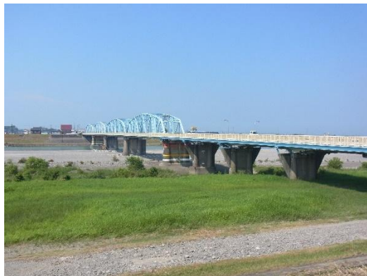
那賀川橋の継ぎ足し（手前側の101m）
