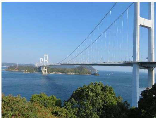
来島海峡大橋
