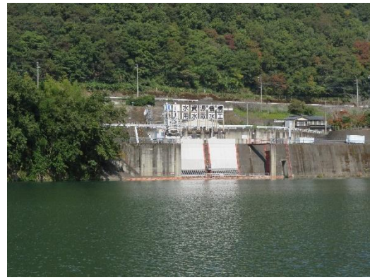
香川用水取水工
