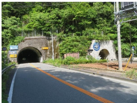
嵐坂トンネル(左)と嵐坂歩道トンネル(右)
