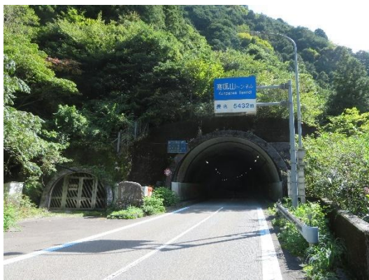
寒風山トンネル(愛媛県側)
