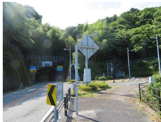
内海トンネル(左)と内海ふれあいトンネル(右)
