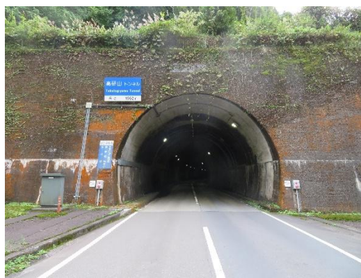
高研山トンネル(梶原側)
