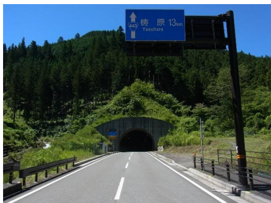
地芳トンネル(柳谷側)
