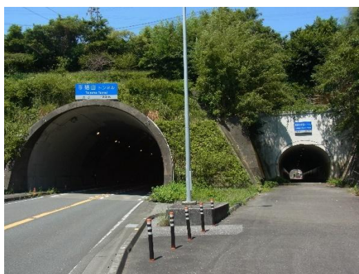
手結山トンネル(左)と手結山歩道トンネル(右)
