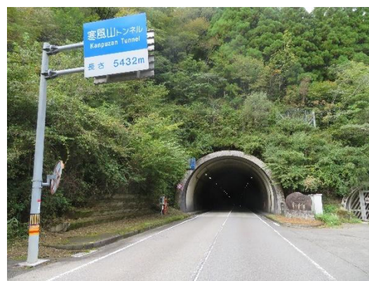
寒風山トンネル(高知県側)
