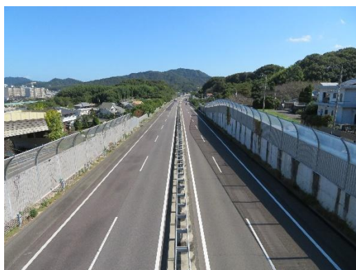
高松自動車道（志度グリーンタウン付近）
