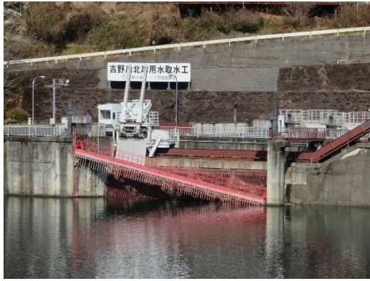
吉野川北岸用水取水工
