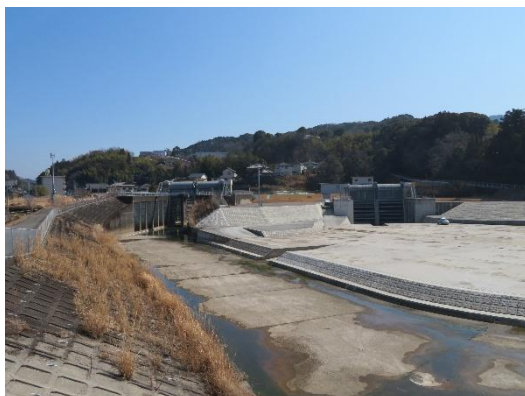
日下川放水路呑口(左)と新日下川放水路呑口(右)
