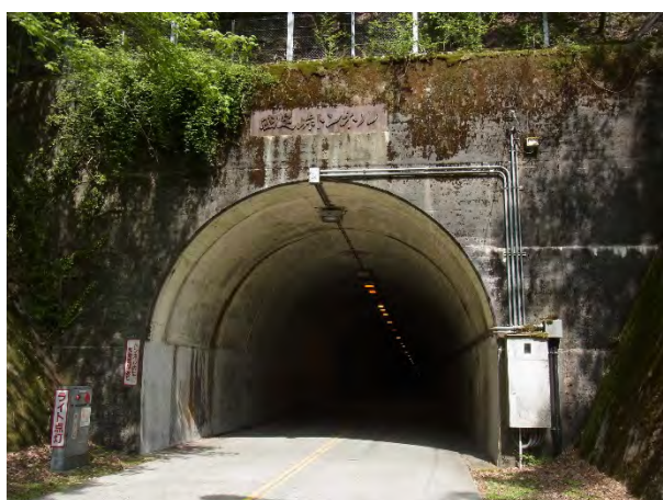
四足峠トンネル（高知県側）
