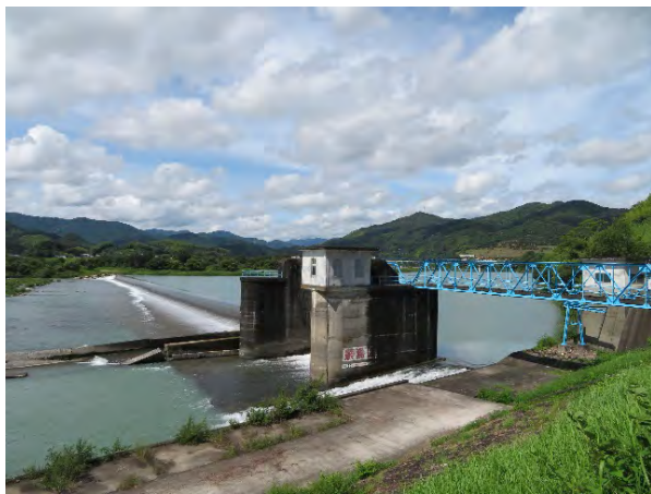
那賀川北岸堰
