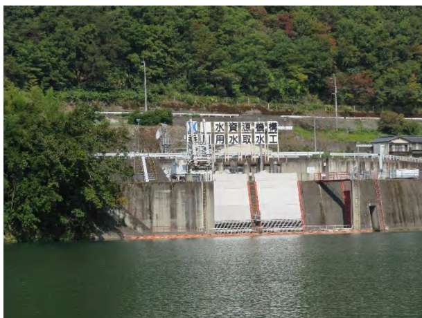
香川用水取水工(池田ダム)
