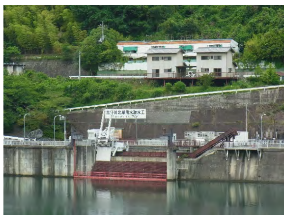
池田ダムの吉野川北岸用水取水工
