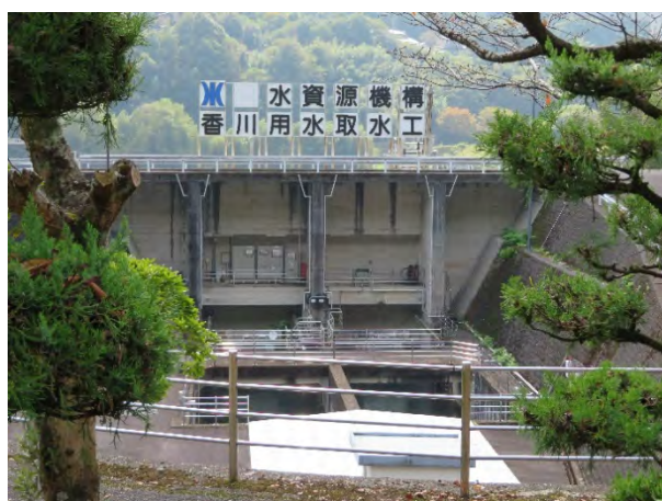
香川用水取水工（池田ダム）
