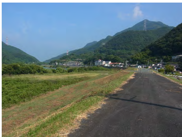
肱川右岸堤防（大洲市白滝）
