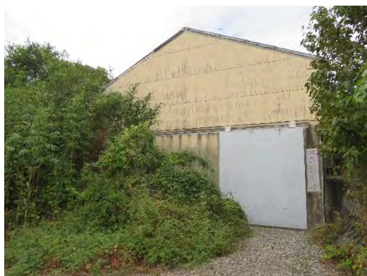
学島排水機場
