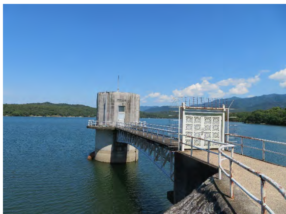
満濃池配水塔
