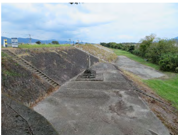
岩津下流左岸堤防
