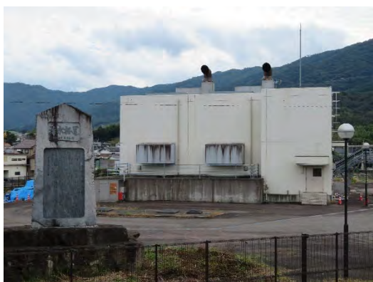
川島排水機場
