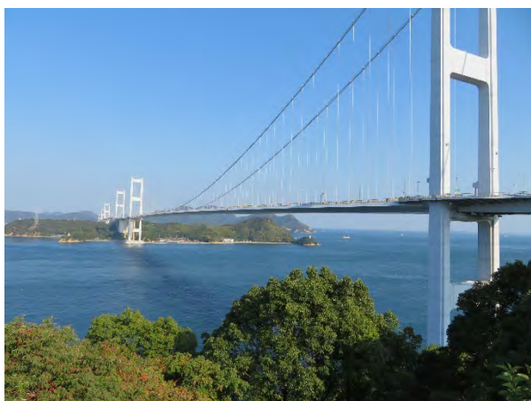
来島海峡大橋
