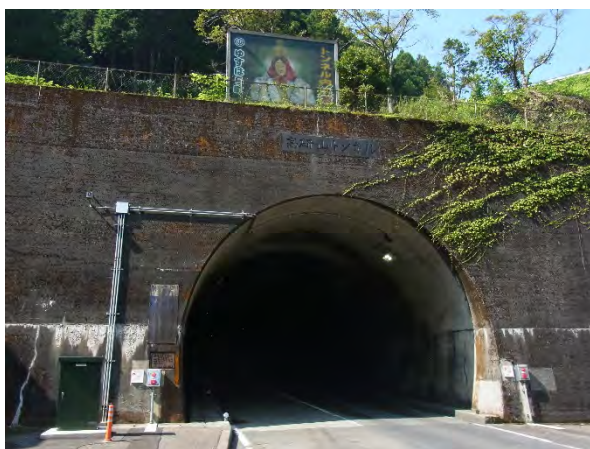
高研山トンネル（梼原側）
