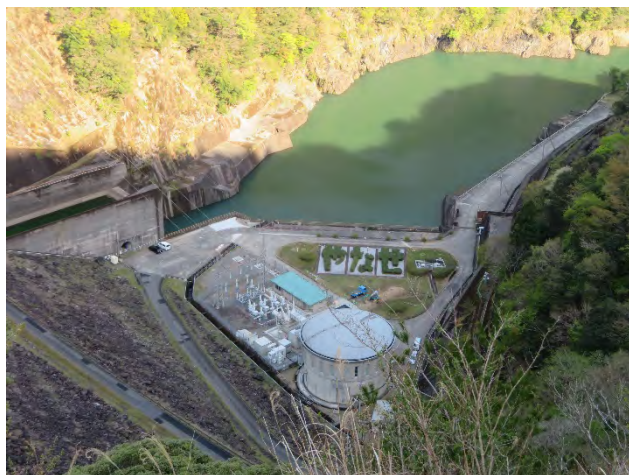
魚梁瀬発電所
