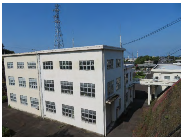
愛媛県銅山川発電所
