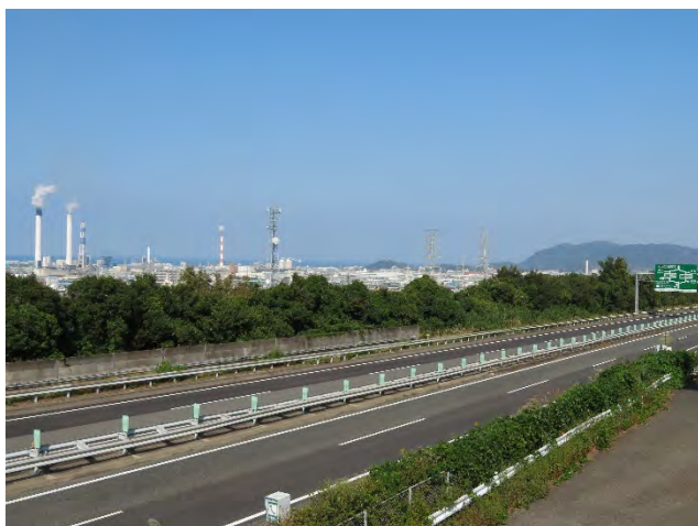
松山自動車道（三島公園付近）
